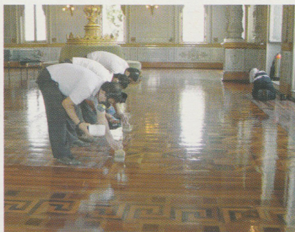
Equipo de restauración y mantenimiento trabajando en el piso del Foyer.
